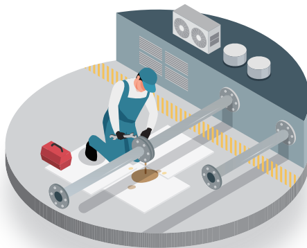
配管フランジの漏油処理
